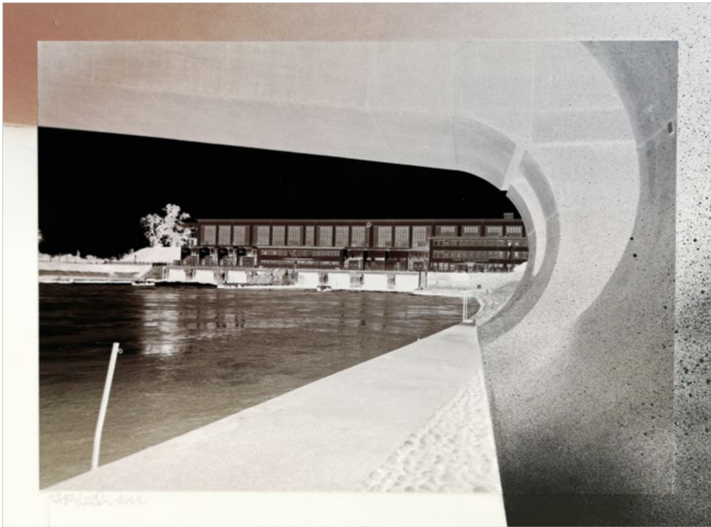
Ottmarsheim, Kraftwerk Ottmarsheim, WVZ 1496
