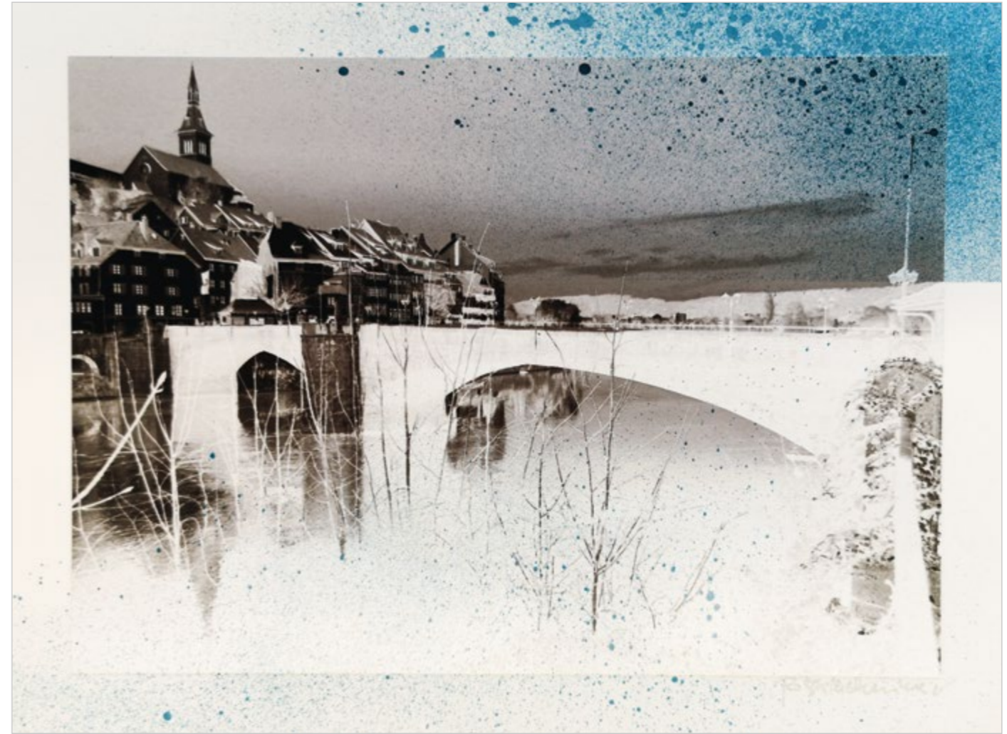
Laufenburg, Laufenbrücke, WVZ 1501
