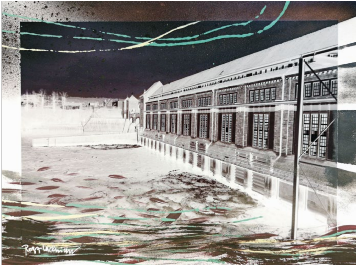
Laufenburg, Kraftwerk Laufenburg, WVZ 1573
